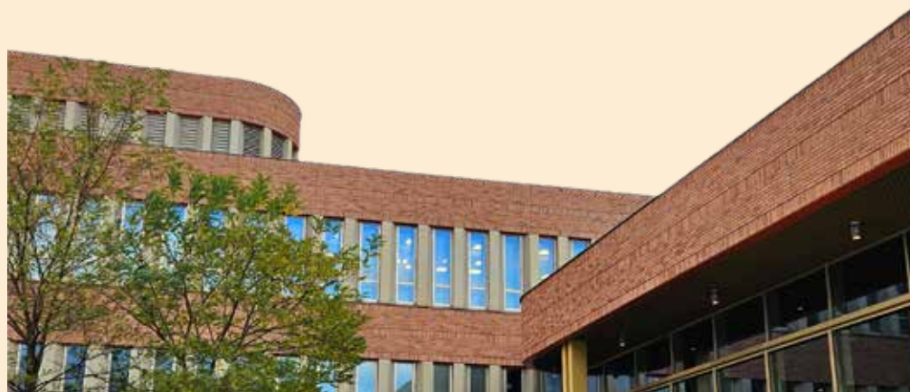
Laurentius Ziekenhuis, mooi gemetseld in baksteen.
