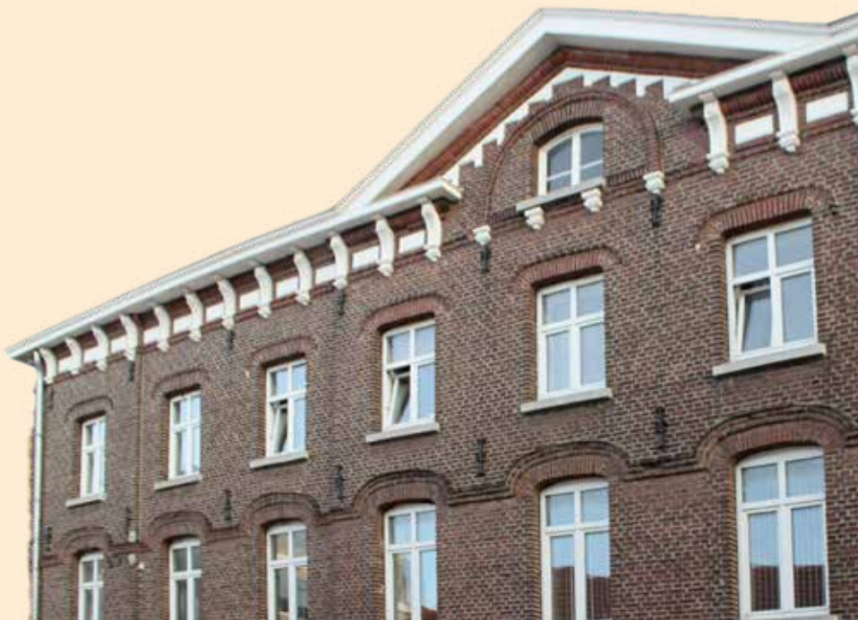
Trekstangen en hanekammen in het hoekpand Munsterplein/ Paredisstraat.
