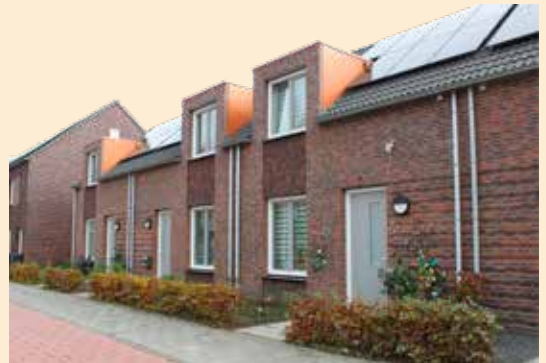
Opstaand metselwerk plus de techniek waarbij twee lagen metselwerk iets naar voren worden gemetseld.
